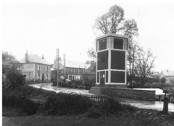
Poste de transformation Badiou à Neuvic. ©Syndicat Diège
